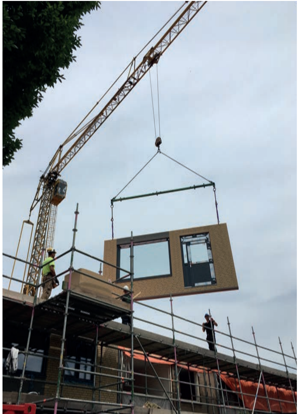
Plaatsing van een nieuwe prefab-gevel.
