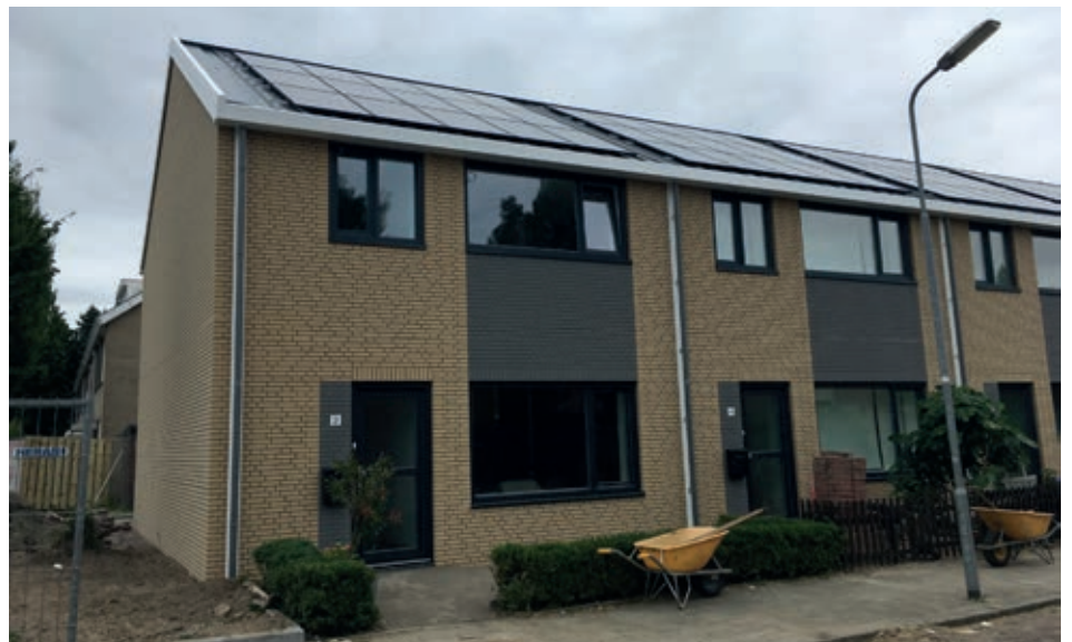
De zonnepanelen compenseren voor het gebouwgebonden en het huishoudelijk gebruik van elektriciteit.
