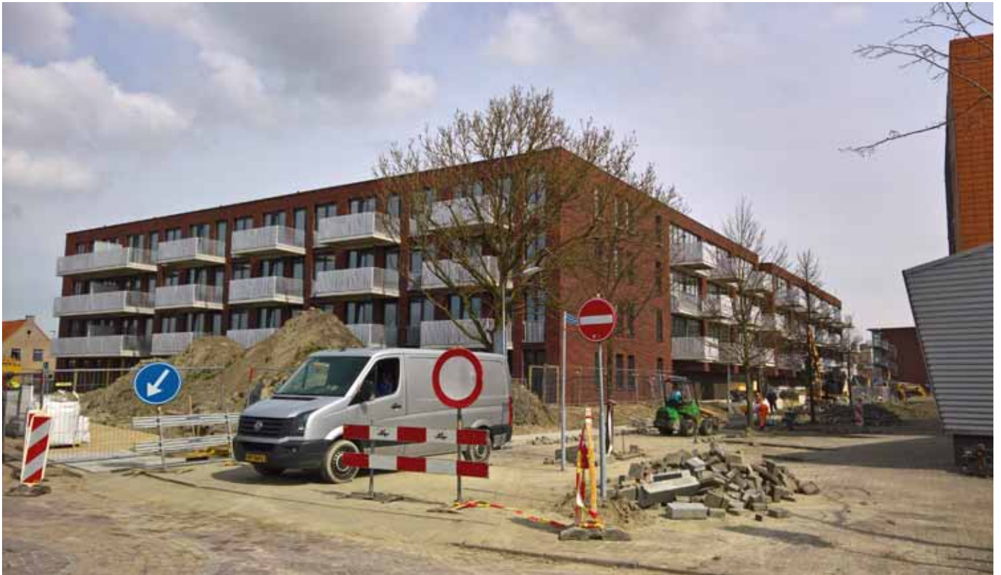
Het appartementencomplex dat in Goes wordt aangesloten op riothermie.
