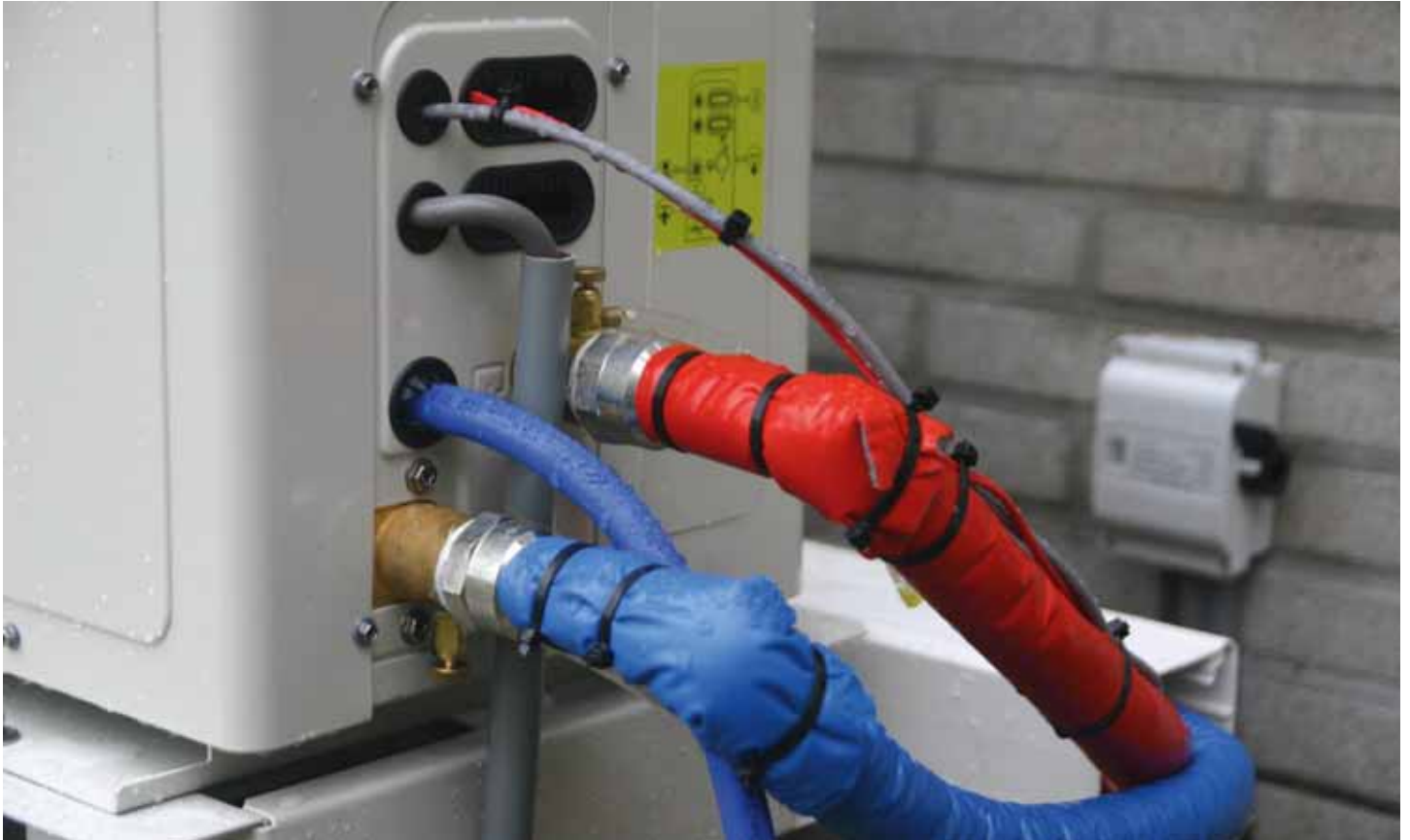
De buitenunit verwarmt cv-water dat vervolgens naar de woning stroomt.
