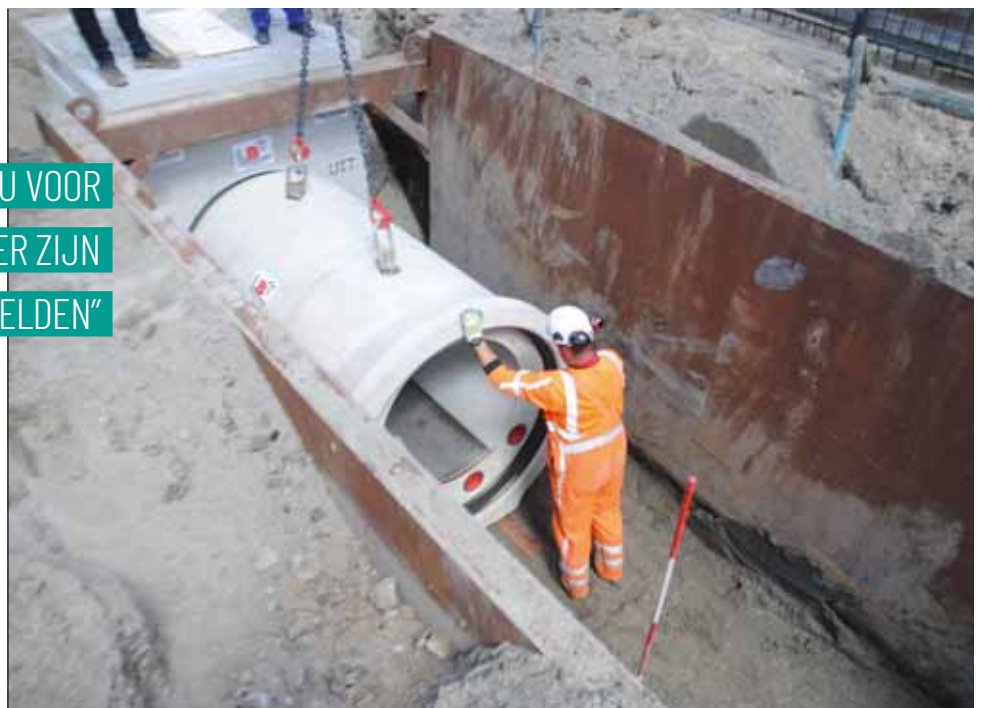
Bij het project in Goes wordt een van de riothermiebuizen op zijn plek gelegd.
